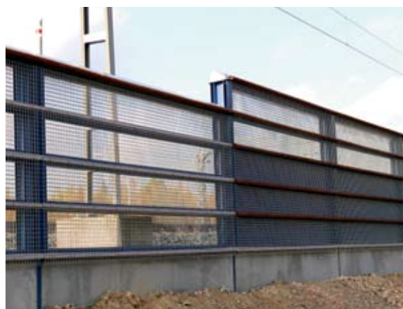
Модульная конструкция позволяет выбрать внешний вид шумовых барьеров по желанию клиента. Для создания прозрачных барьеров можно использовать, например, стеклянные или акриловые листы.
