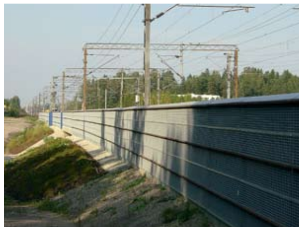
Поливинилдифторидные и полиэфирные покрытия звукоизолирующих заграждений характеризуются длительным сроком службы и простотой технического обслуживания.
