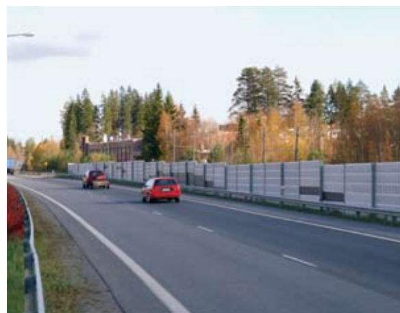
Современные звукопоглощающие барьеры повышают качество жизни на территориях, прилегающих к дорогам с интенсивным транспортным потоком.
