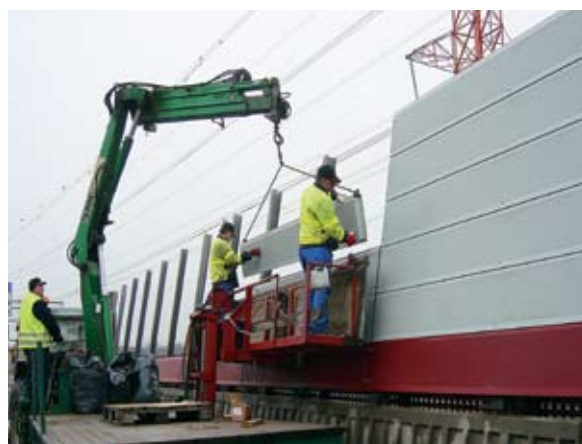
Монтаж кассет шумовых барьеров занимает короткое время. Легкий удельный вес элементов (около 35 кг/м 2 ) позволяет ускорить процесс монтажа и создать безопасные условия работы.
