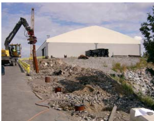
Применение стальных трубчатых свай компании Ruukki позволяет быстро и с минимальными затратами заложить фундамент звукопоглощающих барьеров.
